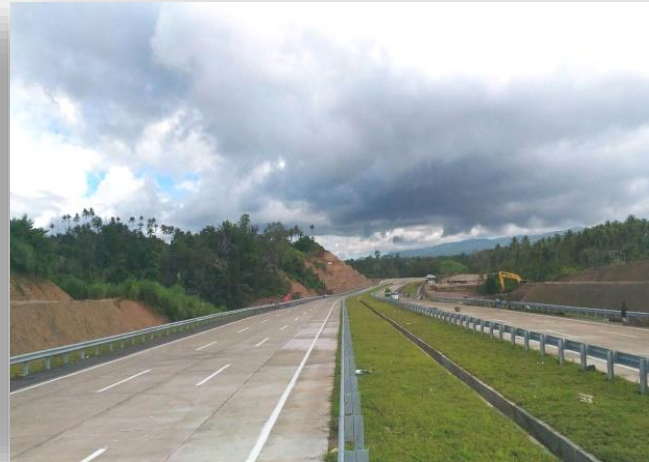
Manado – Bitung Toll Road
